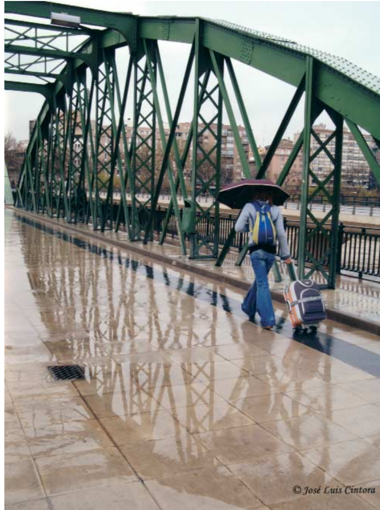
Puente de Hierro
